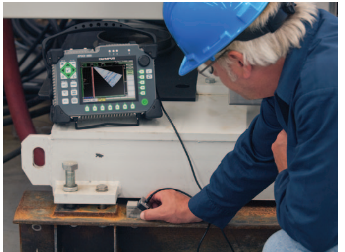
AWS 溶接検査
